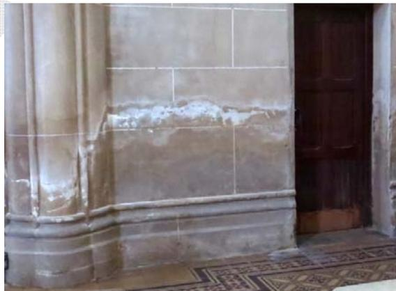
Atraídas por la evaporación, la gran parte de las sales se acumulan en la superficie de las paredes generando las eflorescencias salinas tan comunes en paredes con humedad. Otra parte importante de las sales queda retenida entre
