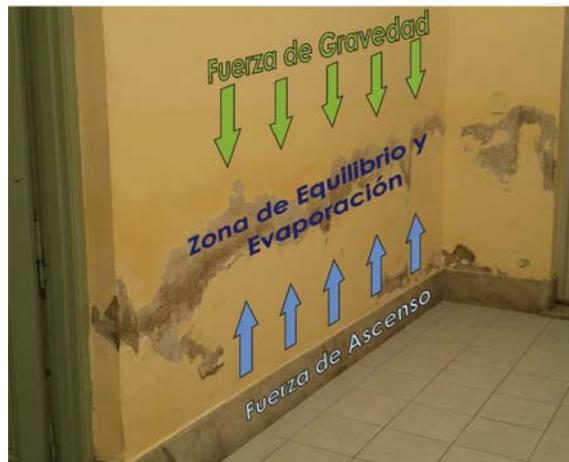
Este ciclo de ascenso, evaporación y concentración, genera la línea característica de deterioro en los muros con humedad capilar.
